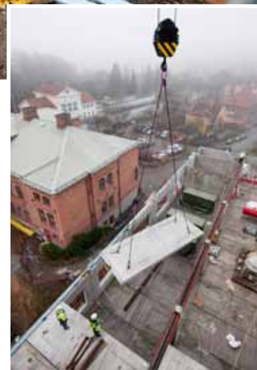
Ett betongelement lyfts på plats och finjusteras manuellt sista biten.
