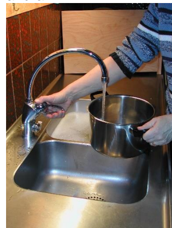
Engreppsblandare och hög kran gör det möjligt att stödja kastrullen när vatten fylls på
